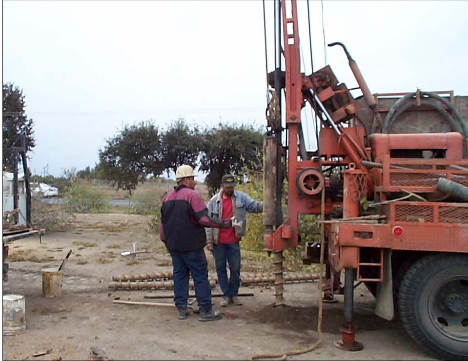
CME 45 Drill Rig
